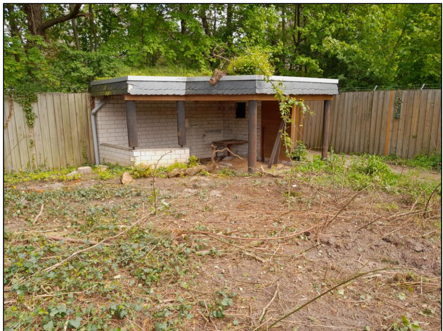
Foto 13: Unterstand im hinteren Bereich des Saunage- landes. Blick nach Osten (Foto vom 02.05.23).
